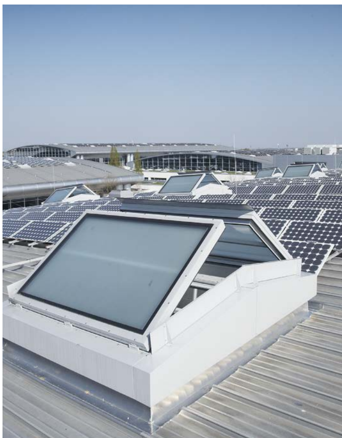
Szabadonálló CI-rendszerű kettős nyílászárny természetes hő- és füstelvezetésként
