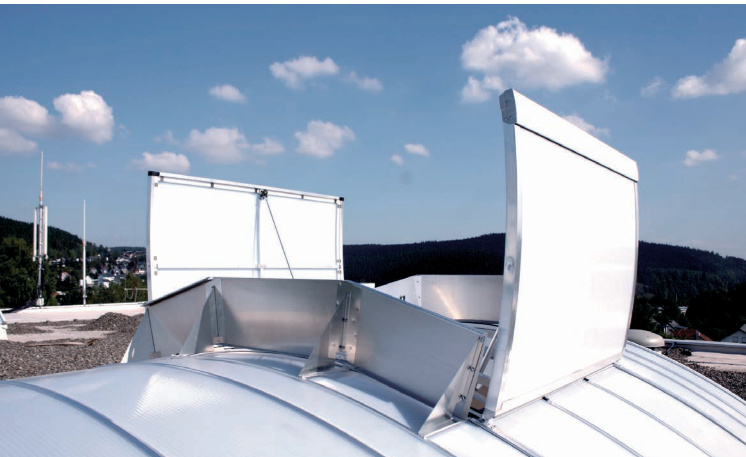
CI-rendszerű nyeregtető sávfelülvilágítóba épített nyílószárny rendszer
