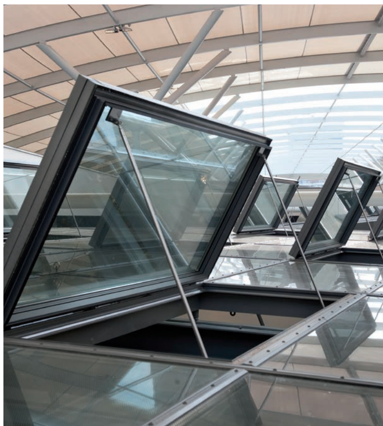
CI-rendszerű üvegszerkezetekbe épített nyílászárny rendszer
