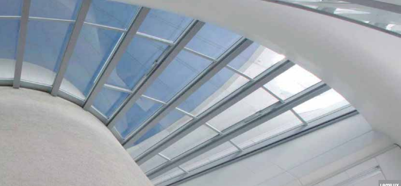
LAMILUX CI-rendszerű KWS 60 üvegszerkezet a müncheni "BMW-négyhengeresben"
